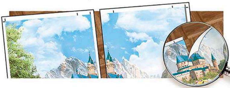
Острым макетным ножом по центру нахлеста прорежьте сразу два полотна.
