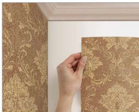
5. Полотна стыкуются строго в углах между стенами с нахлестом 3-5 см.
