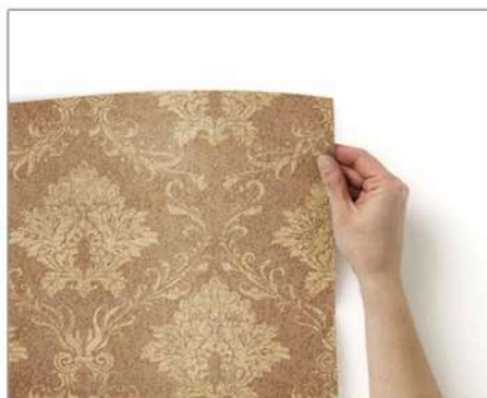
2. Покройте стену клеем и приложите к ней пропитавшееся клеем полотно.
